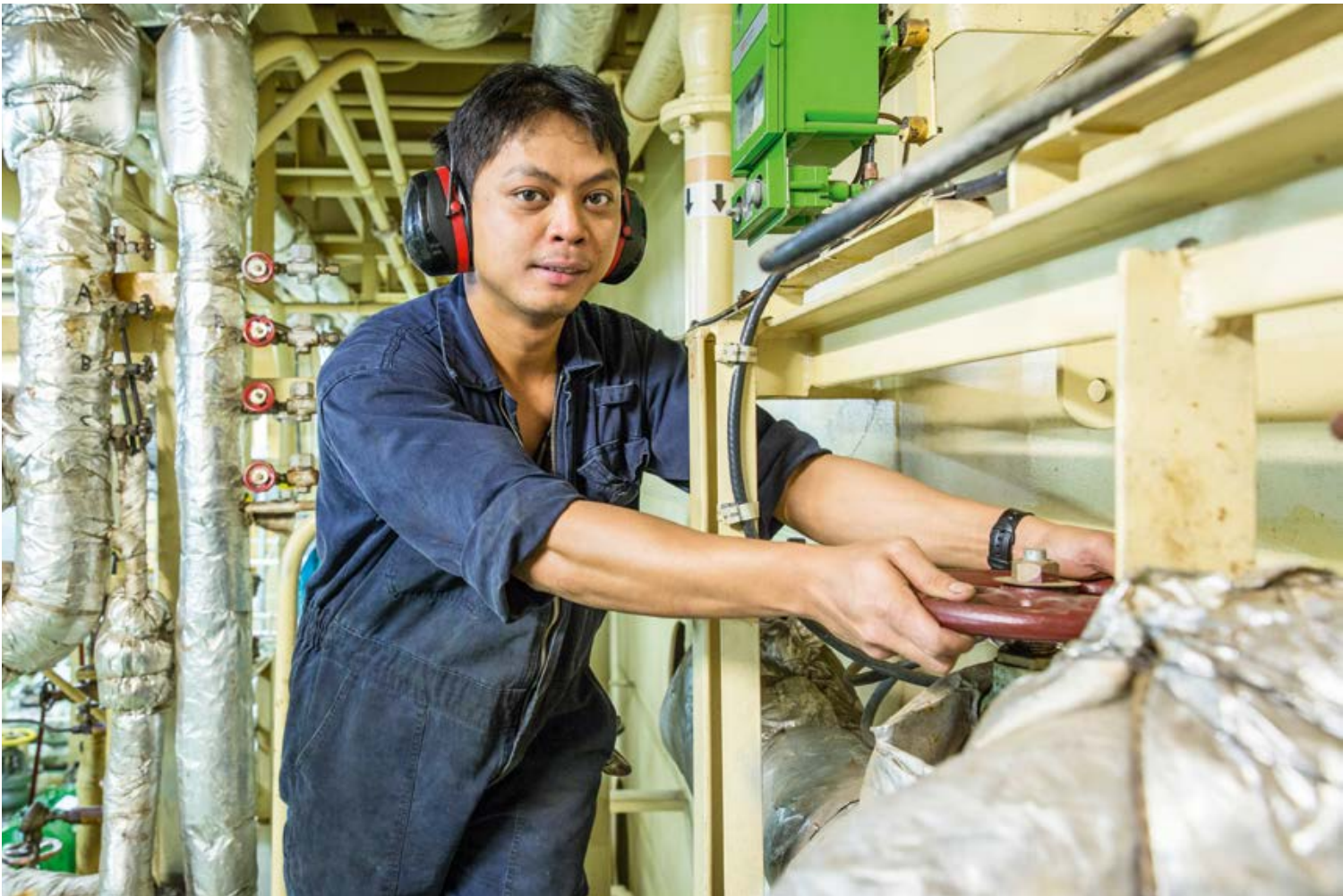
Dreh. Der entscheidende Moment: Leo Padayao, Dritter Ingenieur, öffnet das Ventil, und Low-Sulfur-Öl strömt in das Kraftstoffsystem.
